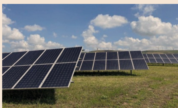
Un impianto LCF
